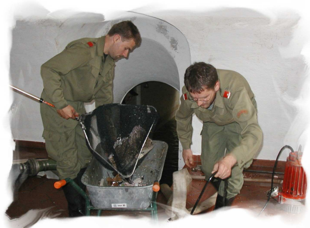
Aufräumungsarbeiten in Kammern - Aug. 2002 Ch. Mladek, M. Allinger
